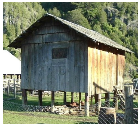
Figura 17. Bodega en altura por roedores y gallinas.
