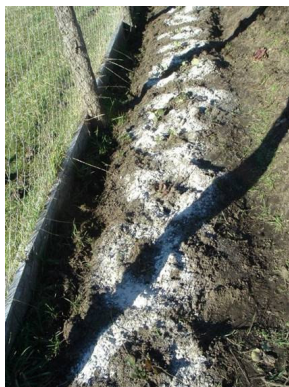
Figura 25. Aplicación de cal.
